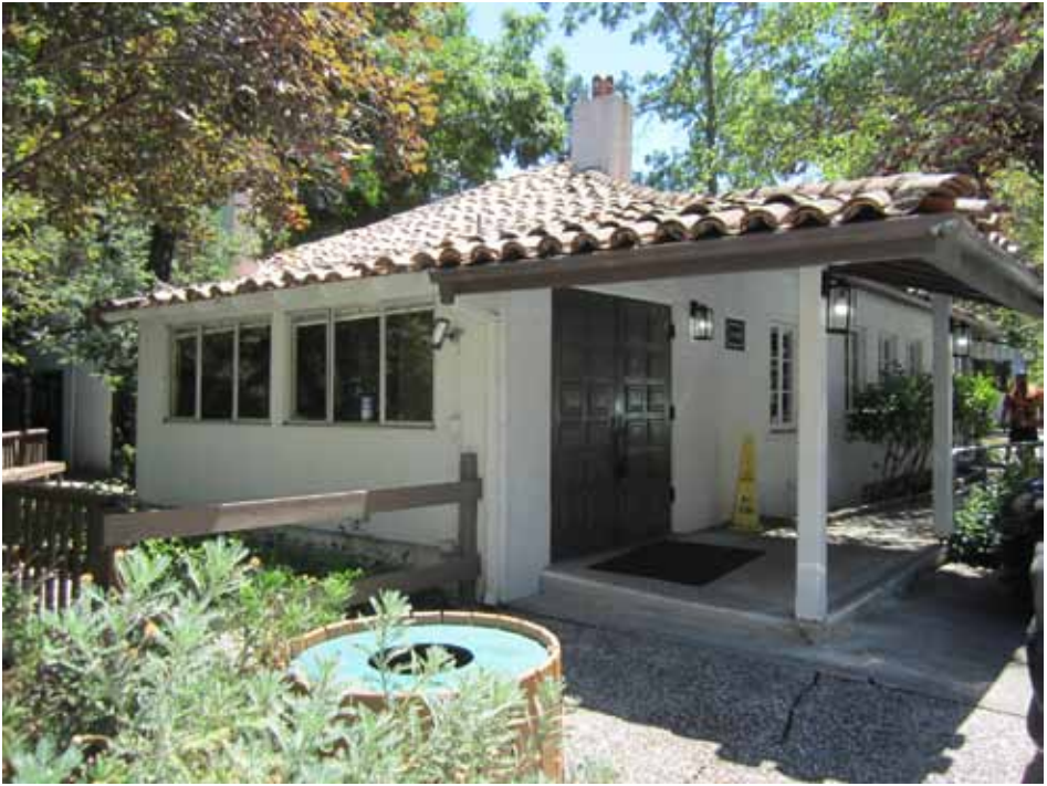
La Sala building at Hacienda de las Flores
